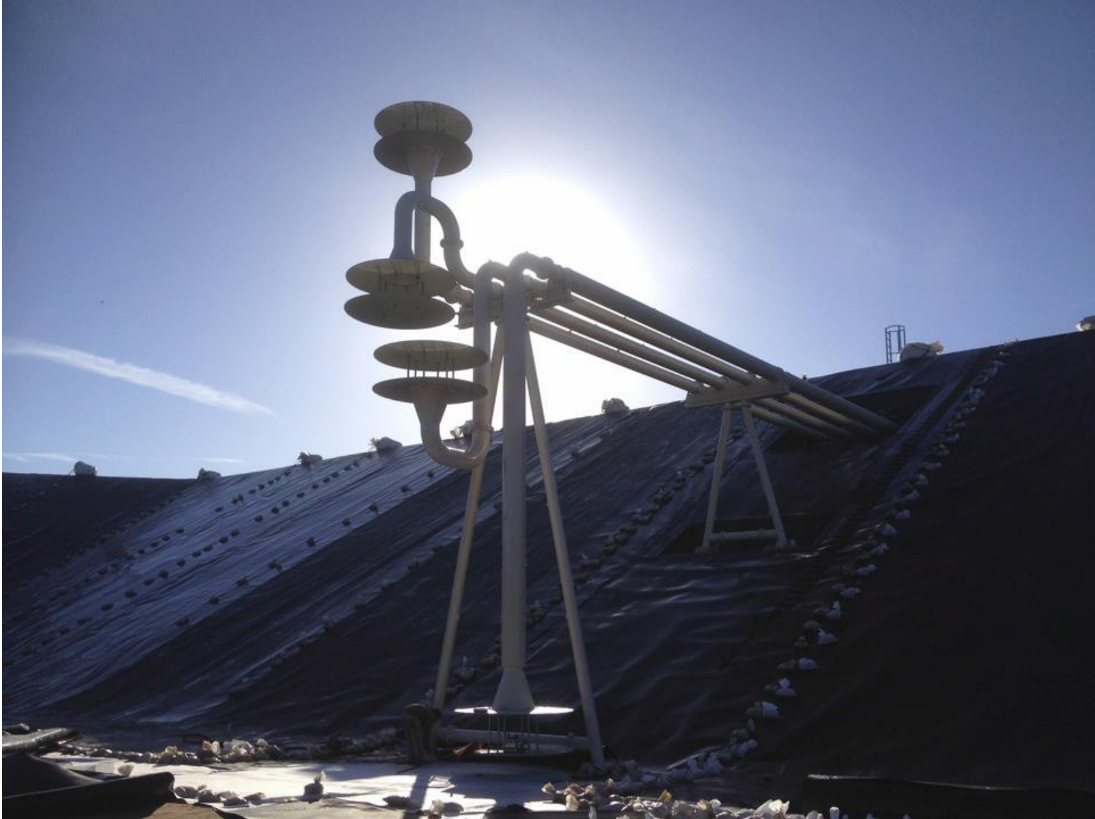
Дистрибуторът на сезонния буфер подава гореща вода в различни слоеве на водния обем
