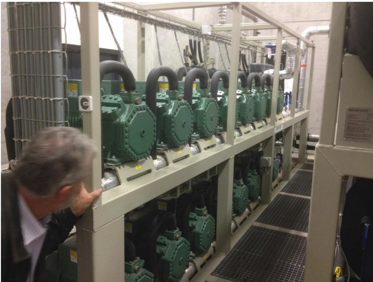
Термопомпен агрегат, който догрива добитата от слънцето топлина
