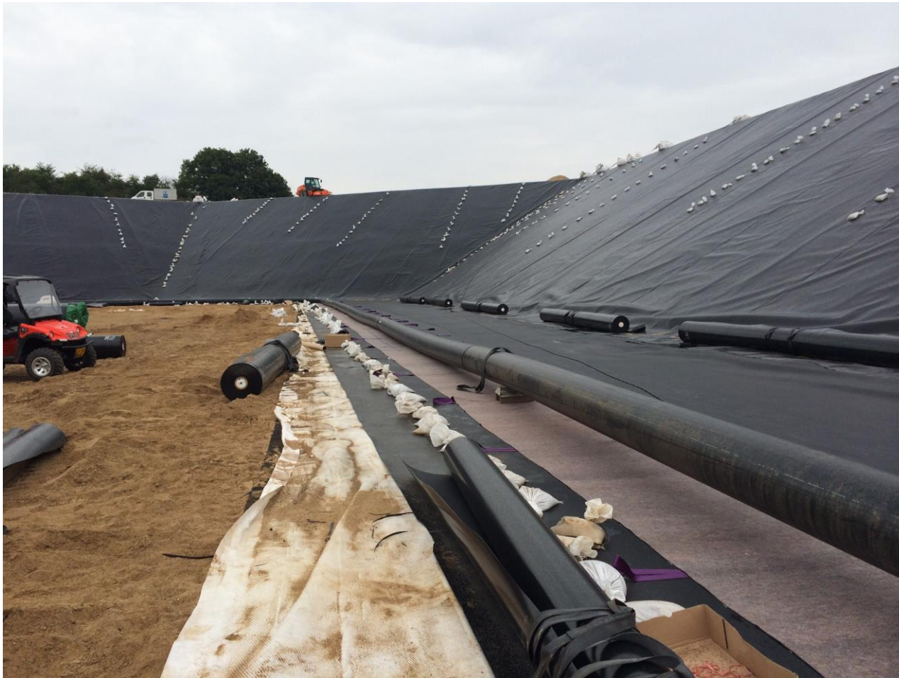
Изпълнение на водния сезонен буфер
